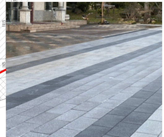
1FL人行道 高壓混凝土磚/仿石材磚 尺寸：30x60 (h)6cm
