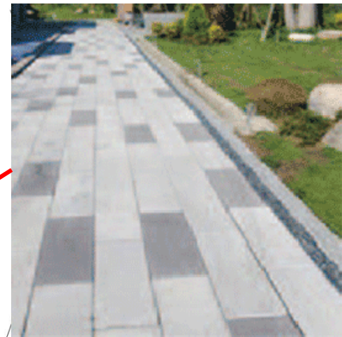
屋頂平台 高壓混凝土磚/仿石材磚 尺寸：30x60 (h)3cm
