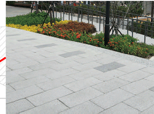
1FL後側空地 高壓混凝土磚/仿石材磚 尺寸：30x60 (h)6cm
